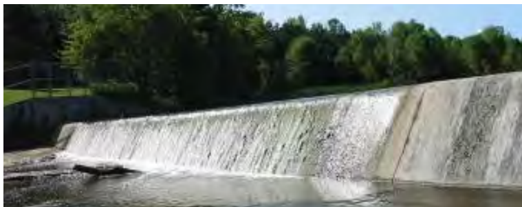
Inspection du barrage, municipalité de Russell
