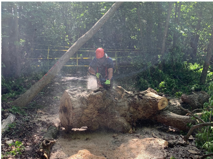
Nettoyage des aires de conservation après la tempête Derecho
