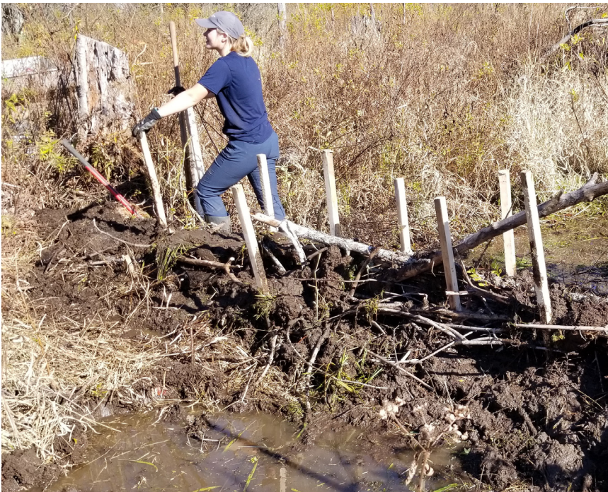
Construction d'analogues de barrage de castors pour la restauration des zones humides
